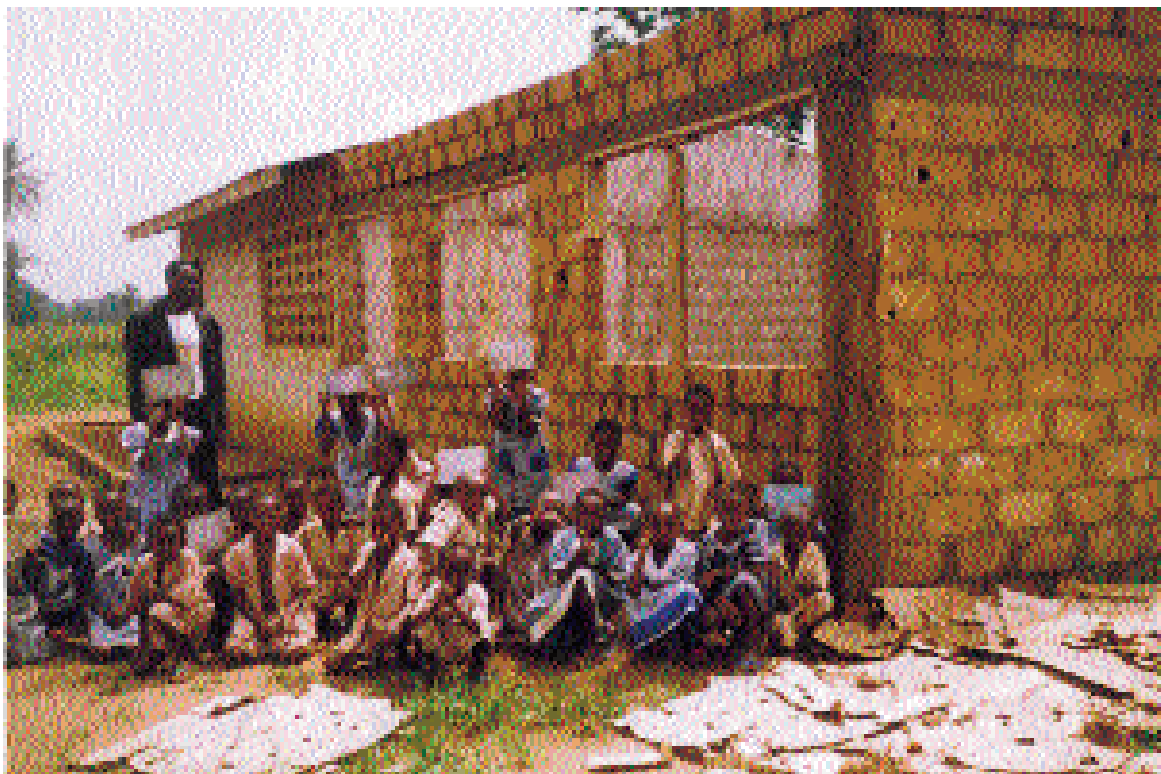
MEDINA: SALA POLIVALENTE IN COSTRUZIONE.
