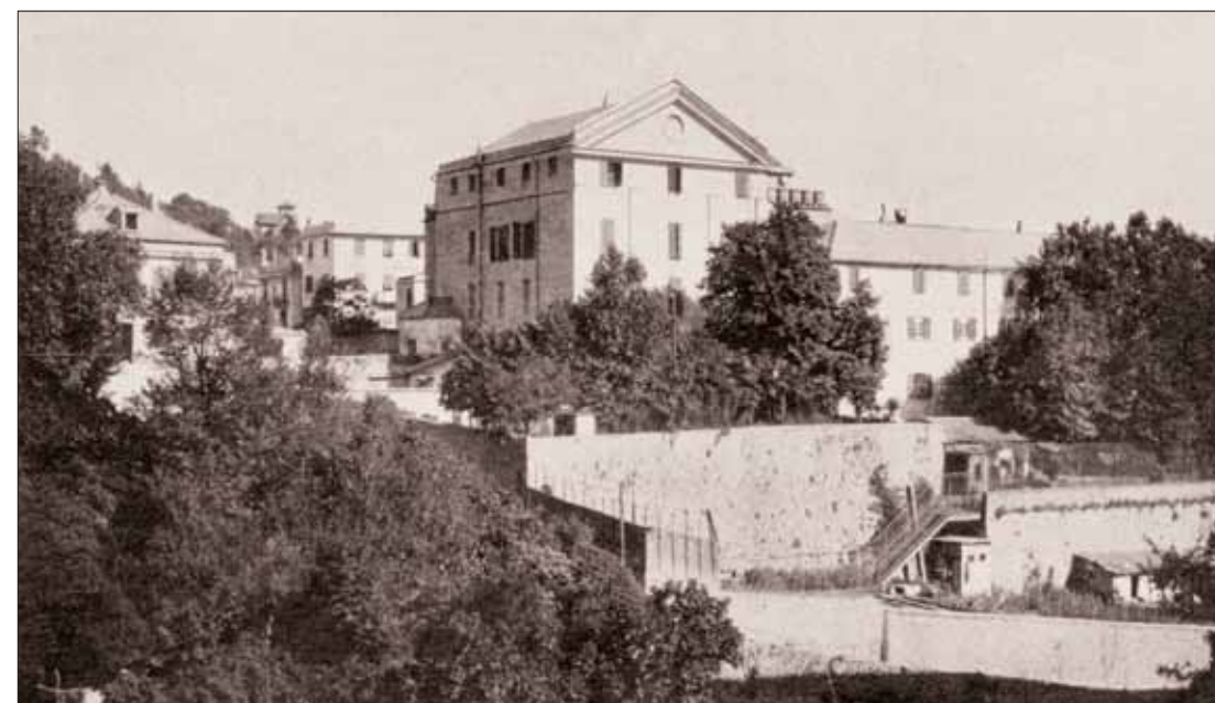
L'antico edificio di Paverano.
