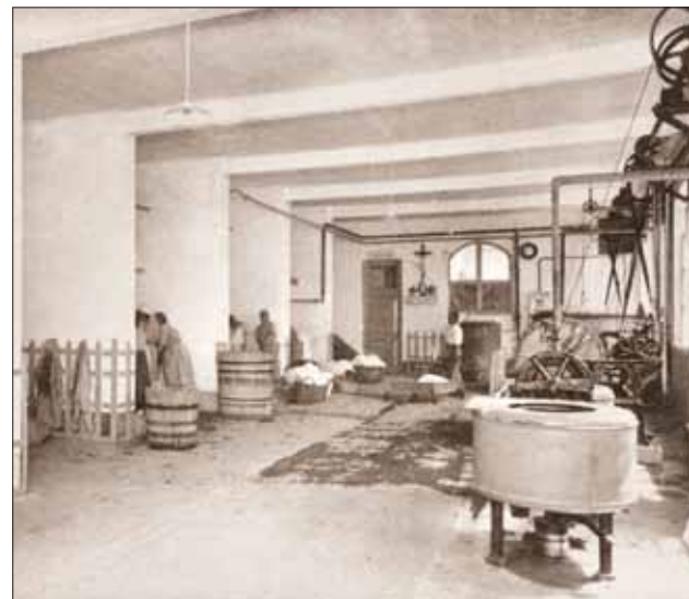
Interno della lavanderia recentemente costruita.
